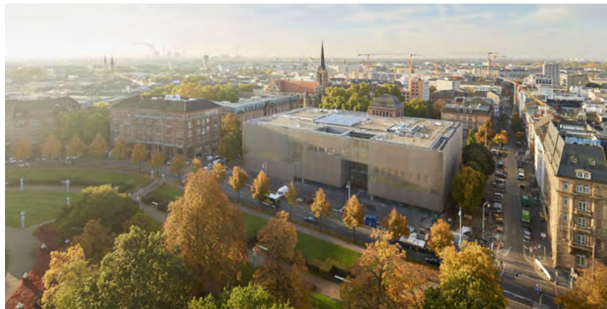
Blick vom Wasserturm auf den Neubau der Kunsthalle Mannheim
